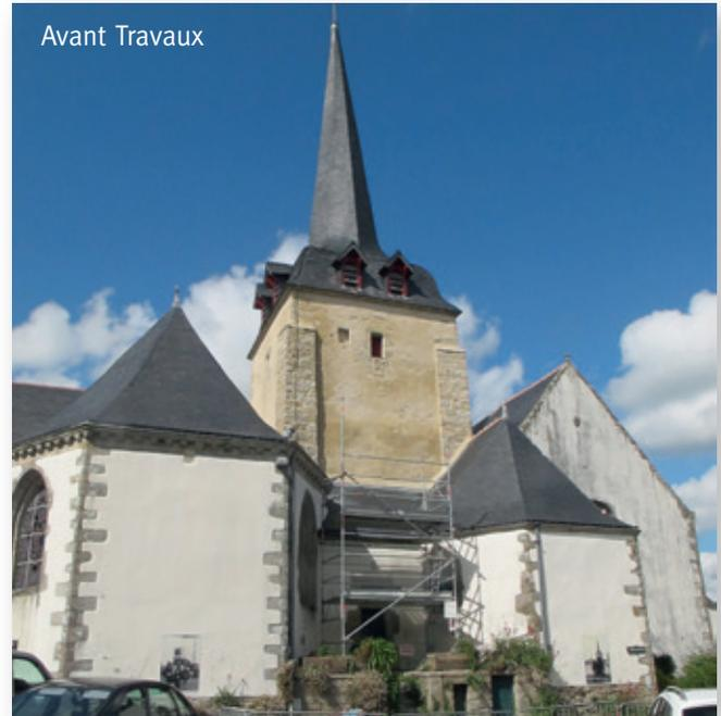
L'ensemble de la couverture et des gouttières a été refait. L'enduit extérieur du clocher a aussi été fait, ainsi que l'installation d'une nouvelle horloge. Pour la suite, c'est-à-dire le ravalement de toutes les faces, les vitraux, les grilles de protection, la charpente du clocher..., cela représente un budget de 900 000 € HT.
