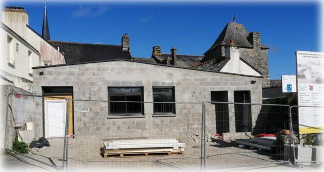
A la date du 10 Juin 2022, l'extension est faite. Reste une petite partie de la toiture, les enduits, et la partie extérieure : auvent et quai. Les aménagements intérieurs, à la charge du Boulanger Nils PENNEC, vont bon train : électricité, plomberie, cloisonnement, chambres froides.
