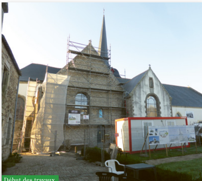
Début des travaux
