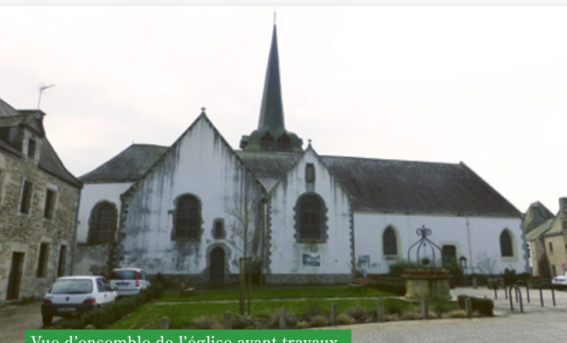
Vue d'ensemble de l'église avant travaux
